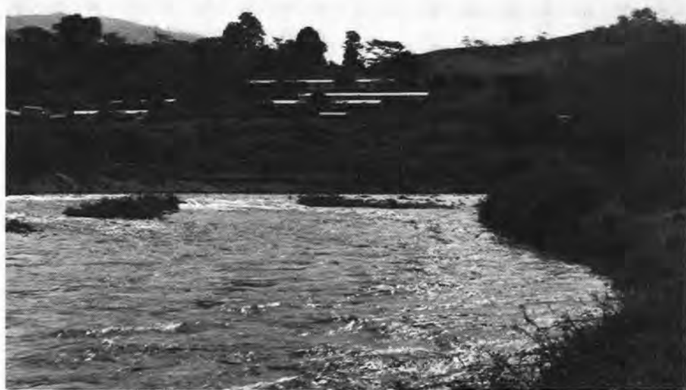
19. The tailrace canal.
