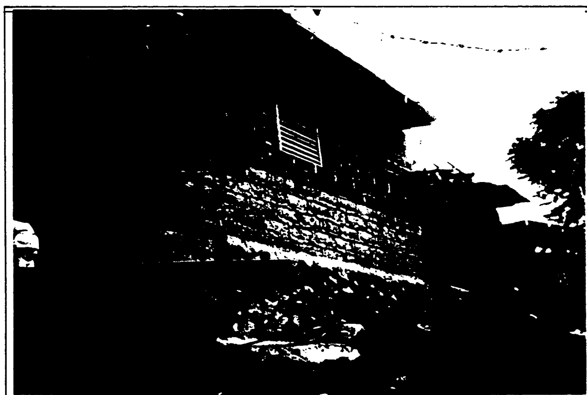
FOTO # 2: FALDA DE PIEDRA BOLON EN VIVIENDA DE ADOBE: UN EXCELENTE METODO PARA EVITAR FILTRACION DE AGUA Y EROSION DE LOS ADOBES: SOMOTO
