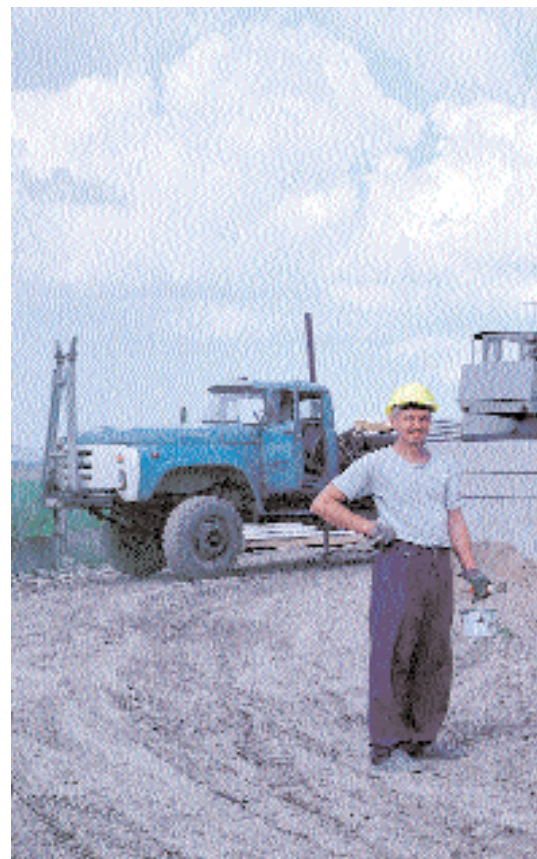
I Haapsalu, Estland, byggdes ett nytt reningsverk.
