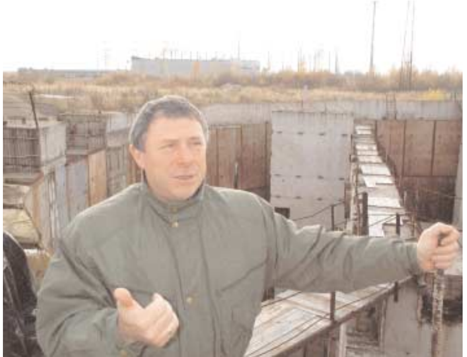
Bygandet av Sydvästra reningsverket i S:t Petersburg avstannade när pengarna tog slut. Nu återupptas det under ledning av bland annat VA-bolagets avloppschef Michail Probinskij.
