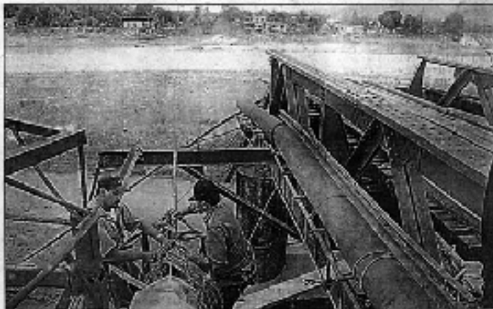
Empleados de la Superintendencia de Telecomunicaciones (HONDUTEL) reparan el puente Cangrejal el sábado pasado para poder comenzar a trabajar con los sectores de Colón, Gracias a Dios, La Mosquitia y parte de Yoro.
