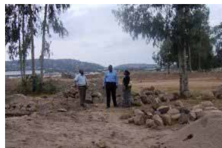
Site for EPC, Mwanza
